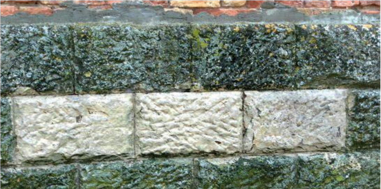
PULITURA MURO IN PIETRA ESTERNO
