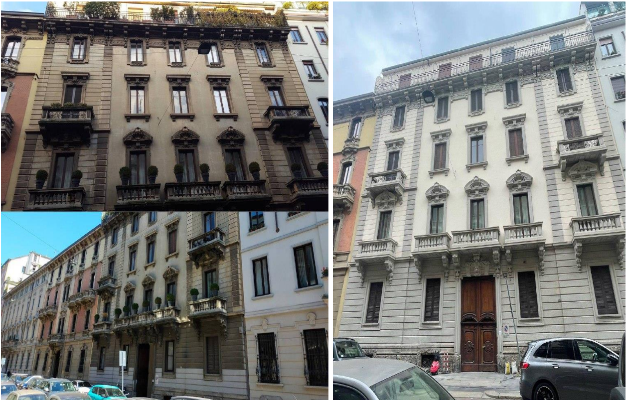
INTERVENTO DI PULITURA FACCIATA TRAMITE SABBIA TAURA
